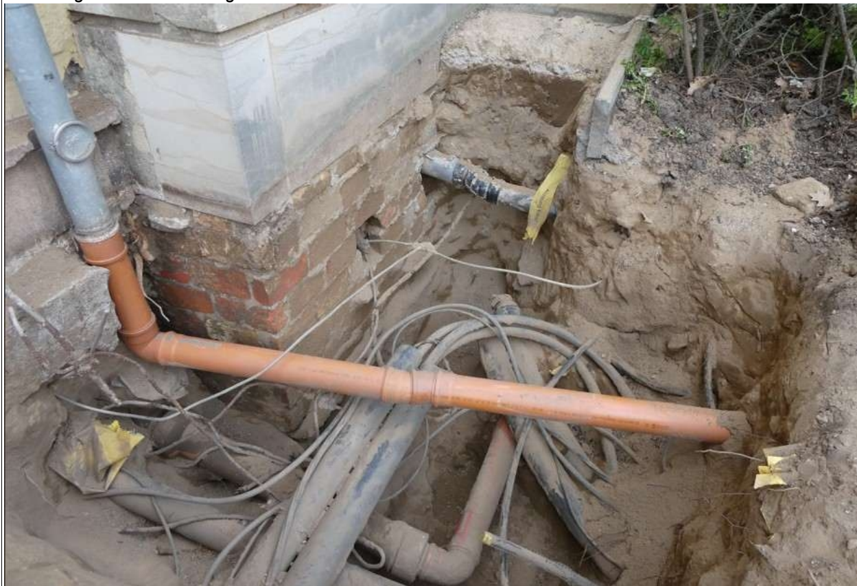
Abbildung - Suchschachtung an der Kelleraußenwand
